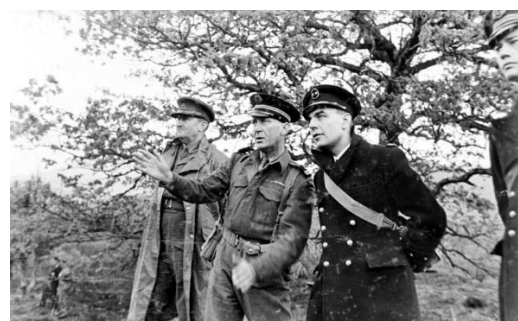
Achnacarry - Au centre, le commandant Philippe Kieffer et l'Amiral Auboyneau © Fondation de la France Libre
